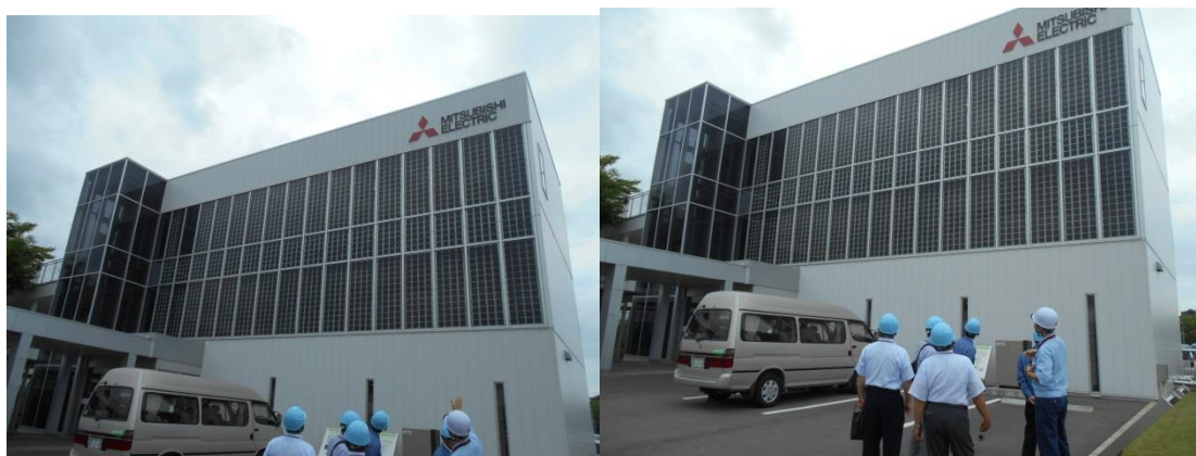
壁面にもソーラーパネルを設置（透過性があり、内部に光が入るようになっている）
