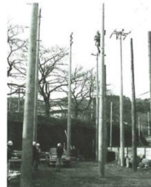
電力柱上安全作業訓練（図ユアテック研修所にて）
