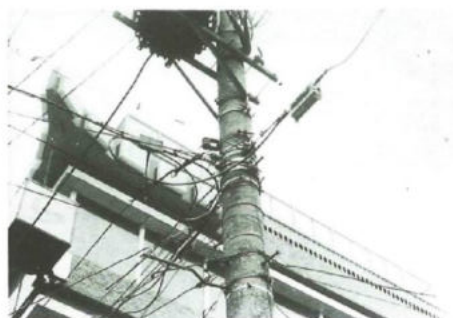
日本ケーブルビジョン (現在の TCV) による新宿でのわが国最初の施設工事 (昭和45年)
