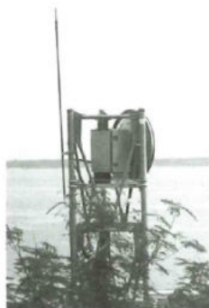
沖縄県宮古島より伊良部島へのCATV伝送用無線装置(23GHz, 昭和55年)
